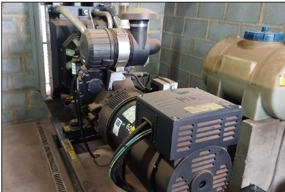
ITEM 0061 - GERADOR DE ENERGIA - 140KVA - 220/380/440V
