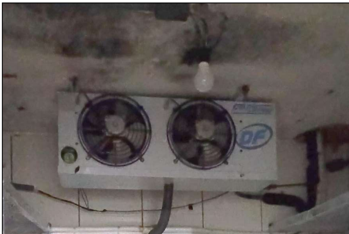
ITEM 0060 - MOTOR E FORÇADOR PARA CAMERA FRIA
